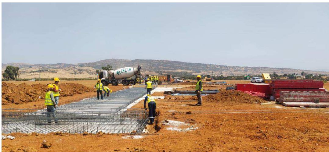
Installation des bureaux des sous-traitants
