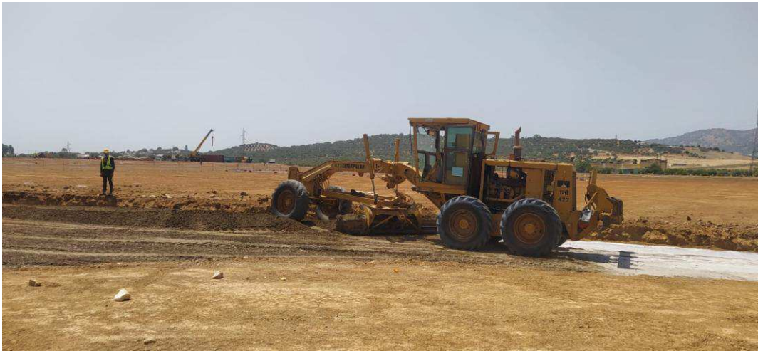
Travaux des voies intérieures
