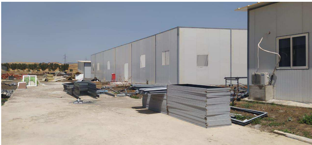
Travaux d'installation de chantier
