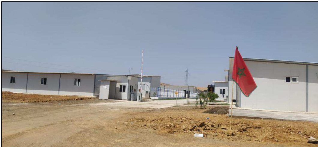
Bureaux de chantier
