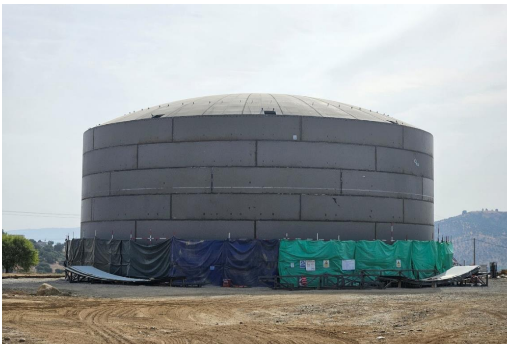
Assemblage des reservoirs de fuel
