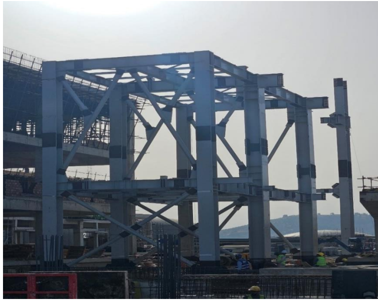
Montage de la structure : Pont roulant des turbines
