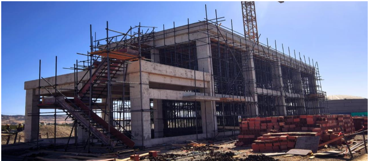
Travaux de maçonnerie : bâtiment de pompage multifonctionnel
