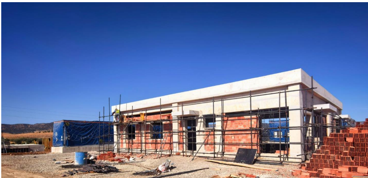
Travaux de maçonnerie : bâtiment Black-Start
