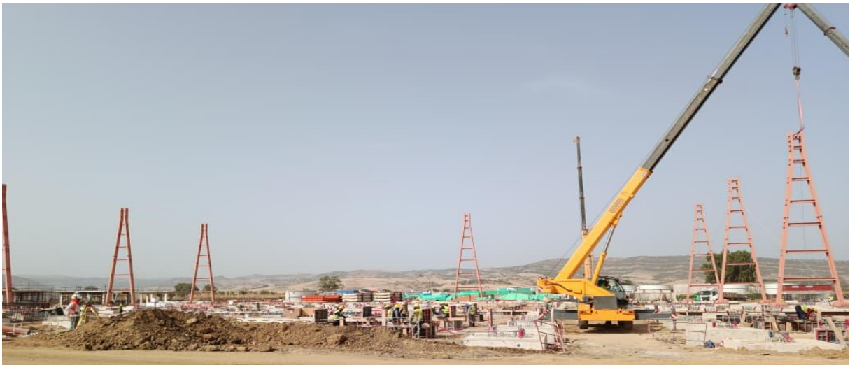
Montage de la structure métallique de la charpente principale du poste 400kV
