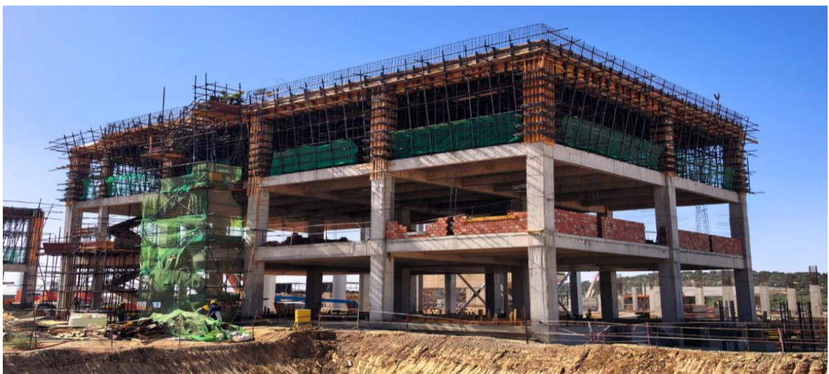
Travaux de maçonnerie : bâtiment électrique 1
