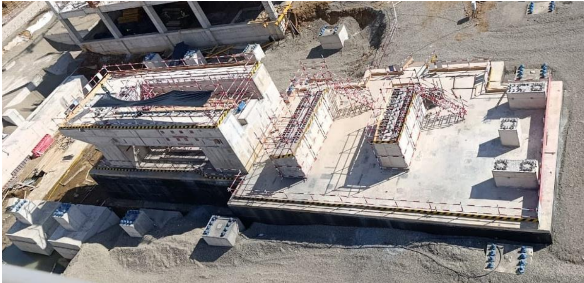
Fondations de la turbine 1
