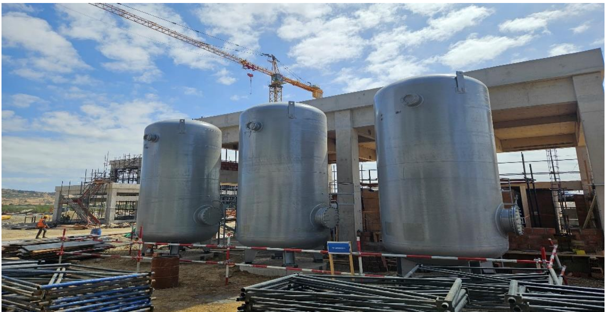
Pose des équipement d'air comprimé
