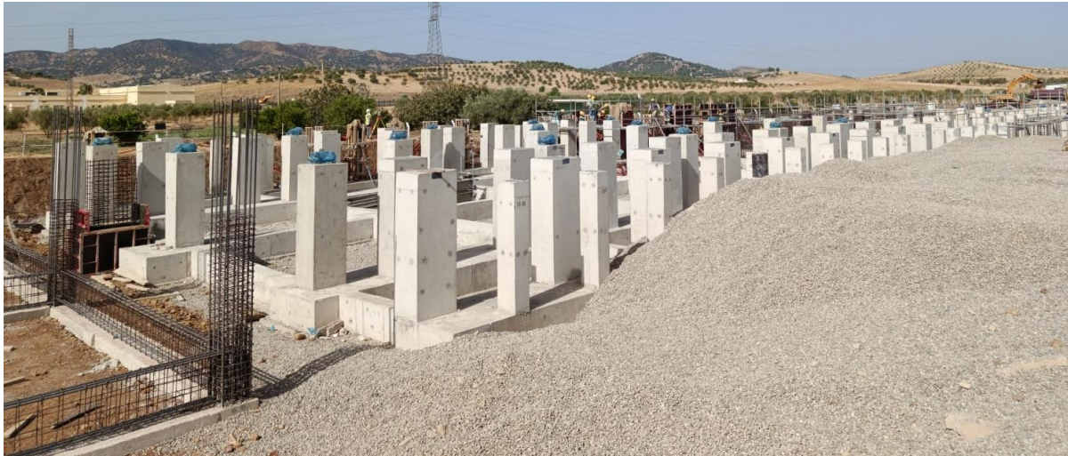
Bétonnage des poteaux : Tours de refroidissement
