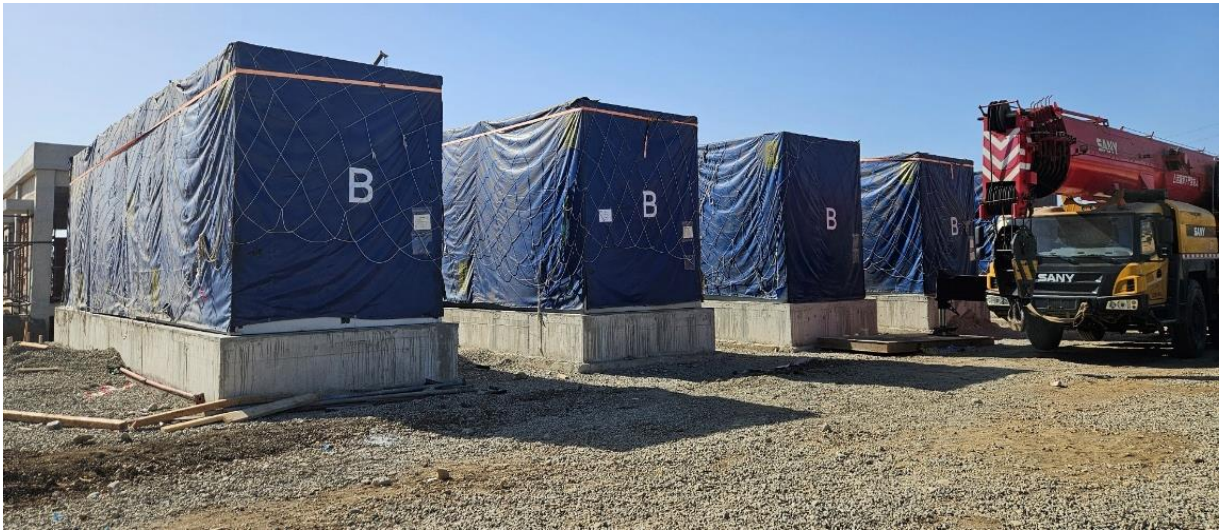
Pose des groupes diesel du Black-Start
