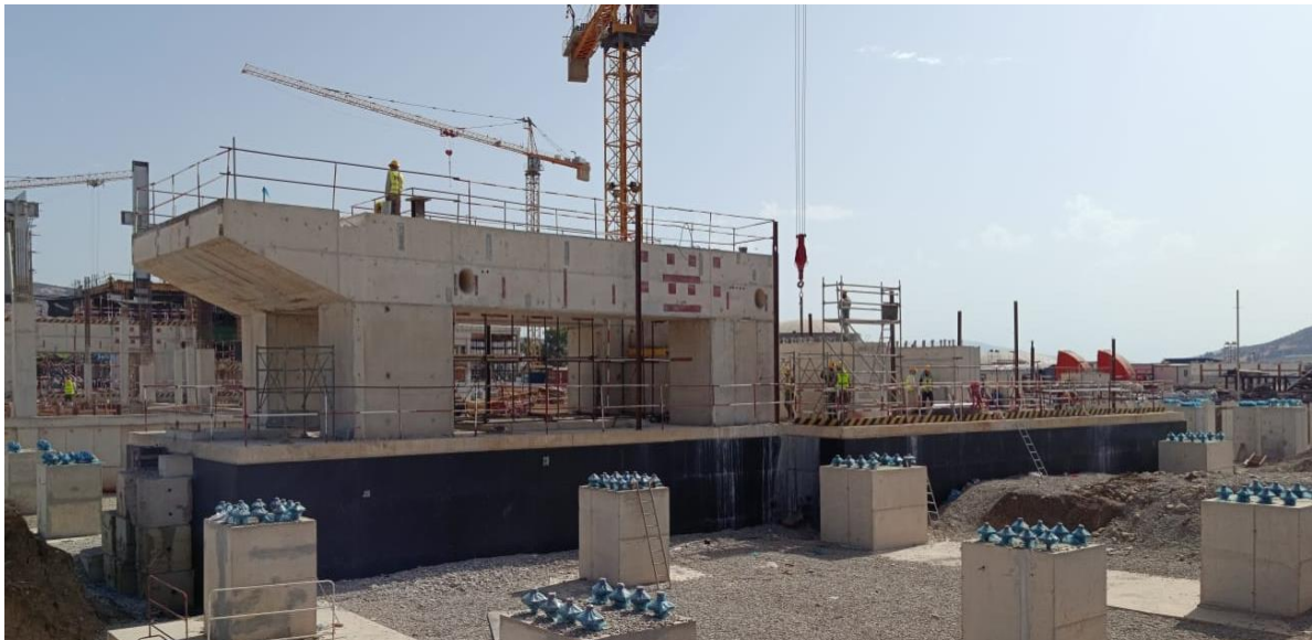
Fondations de la turbine 2
