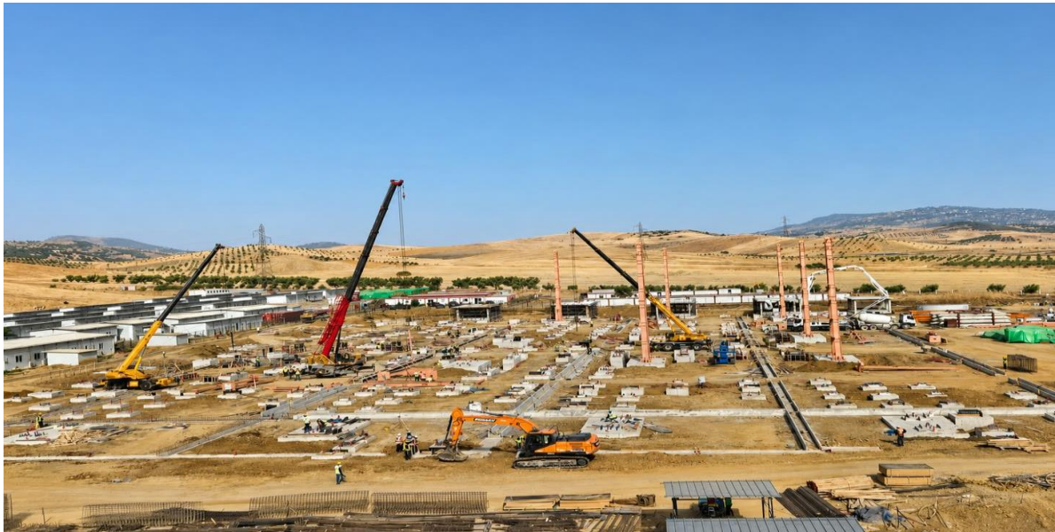
Coulage des fondations : charpente secondaire du poste
