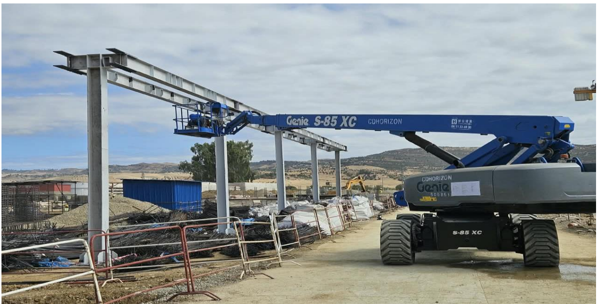
Montage de la strucure métallique du piperack
